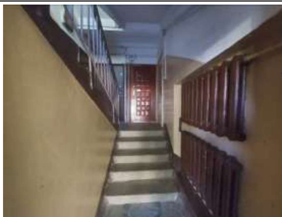
1.stāva kāpņu telpa
